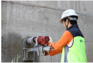
1. 콘크리트 코어 채취
