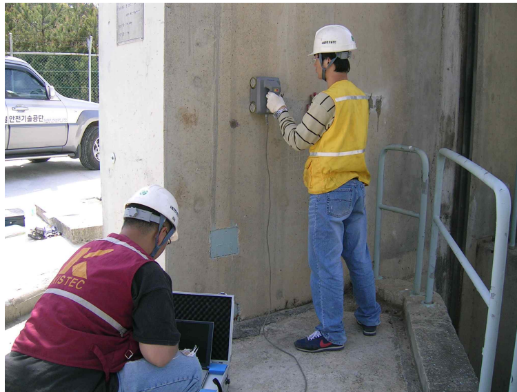
[해설 사진 2.4.8] Iron-seeker를 이용한 철근배근탐사
