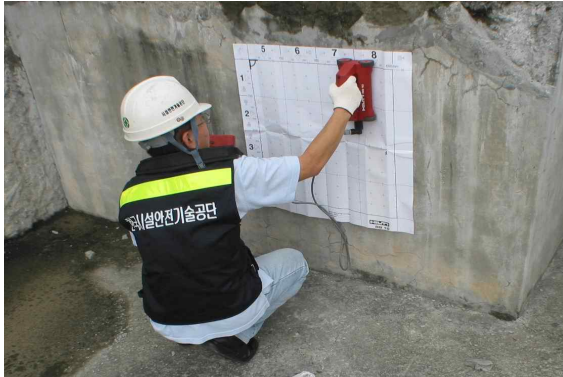
[해설 사진 2.4.5] Ferroskan RV-10을 이용한 철근탐사시험 전경
