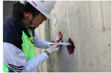
3. 탄산화 깊이 측정
