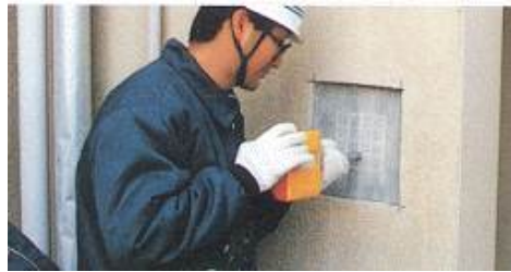
[해설 사진 2.1.4] 측정면이 몰탈 등일 경우의 측정 광경
