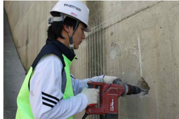
2. 철근 노출 작업
