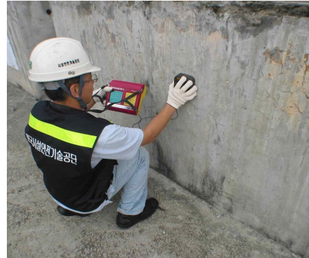
[해설 사진 2.4.6] Profometer 4를 이용한 철근탐사장면
