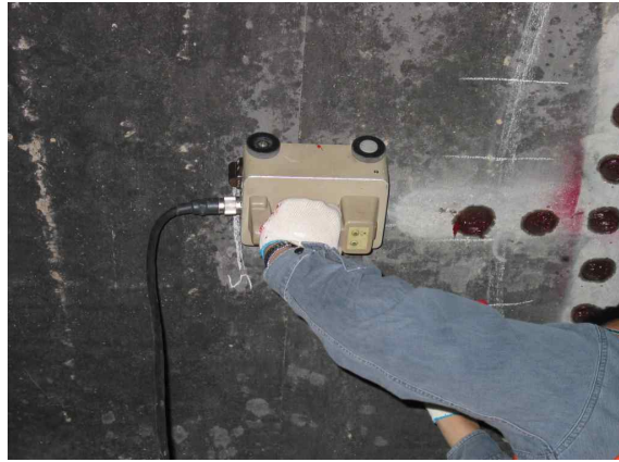
[해설 사진 2.4.7] RC-Radar를 이용한 철근배근탐사
